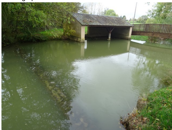
Déversoir à l'amont du lavoir et de l'ouvrage ROE
