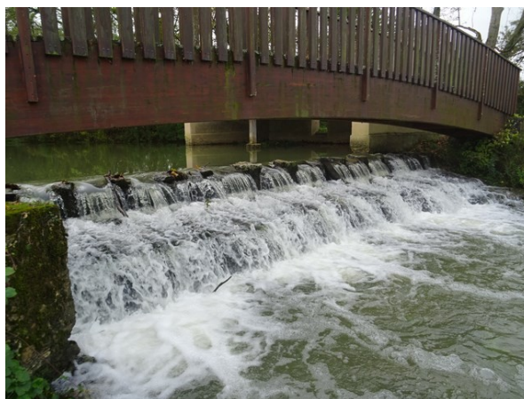
Ouvrage ROE (vue aval RG)
